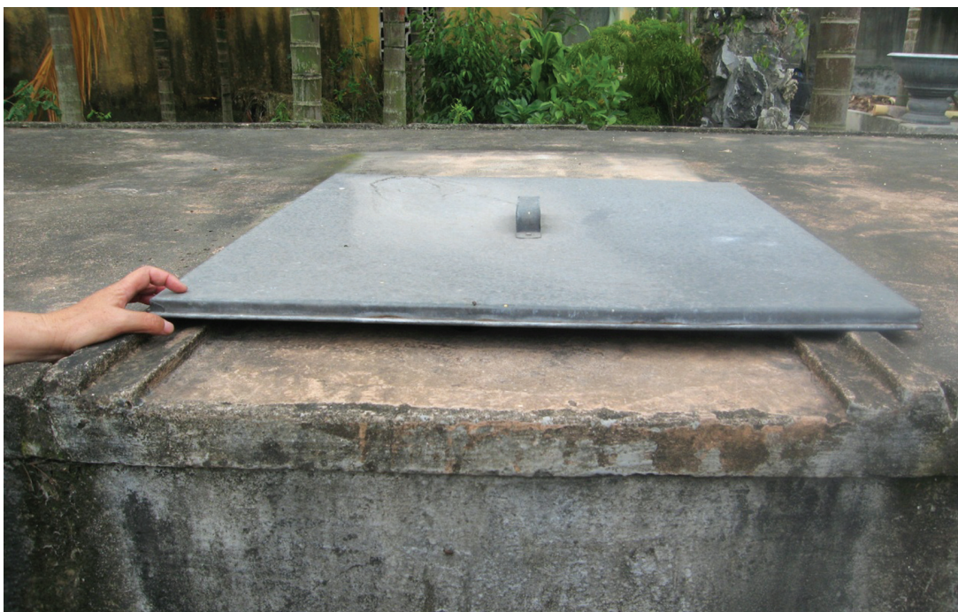
Hình 7. Nắp đậy bể nước
